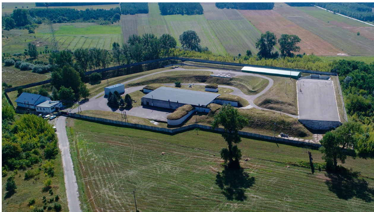
Fot. 5. Krajowe Składowisko Odpadów Promieniotwórczych w Różaniu (fot. ZUOP) Photo 5. The National Radioactive Waste Repository in Różan (photo: ZUOP)
