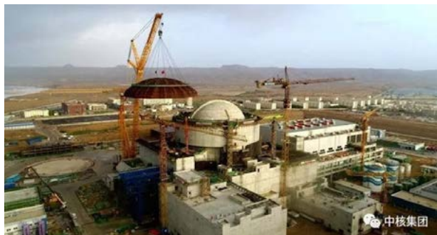
Fot. 4. EJ w Pakistanie. Nałożenie kopuły obudowy bezpieczeństwa (fot.GCR) Photo 4. China Tops out Hualong One nuclear plant in Pakistan (By GCR Staff)
