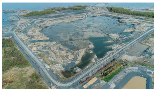
Fot. 2. Prace makroniwelacyjne pod główne budynki: reaktorownię i maszynownię, stan na dzień 28.05.2019 (fot. Fennovoima, CC BY-NC-ND 2.0). Nie zainstalowano jeszcze systemu drenażowego, czego efektem jest widoczny na zdjęciu wysoki poziom lustra wody.
